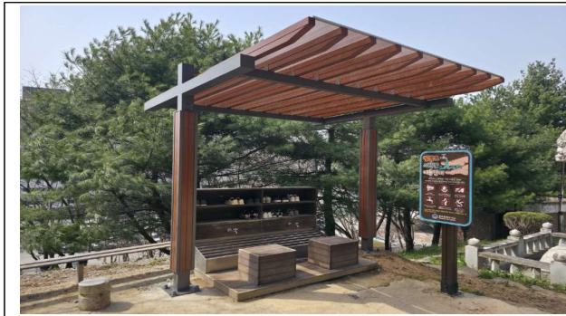
【세족장 비가림막 설치】
